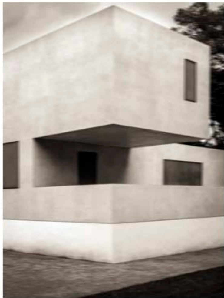
Neue Meisterhäuser Dessau, Haus Gropius, Teilansicht
