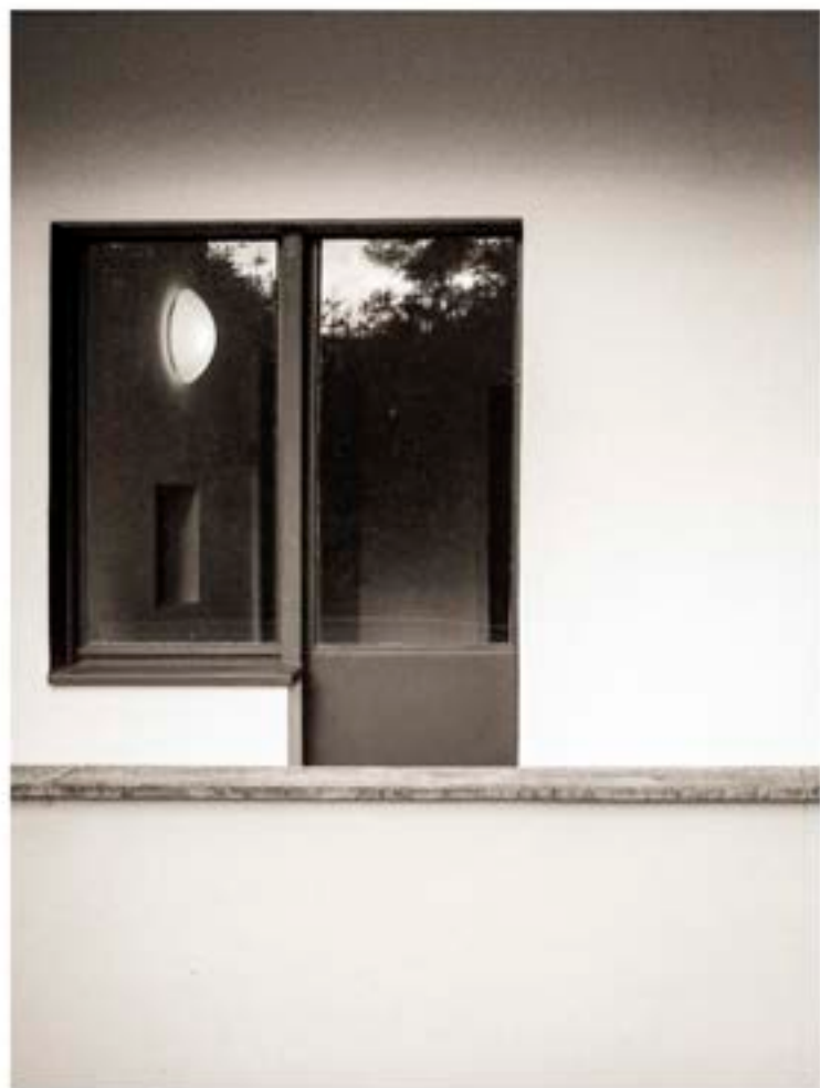
Meisterhäuser Dessau, Haus Feininger, Detail
